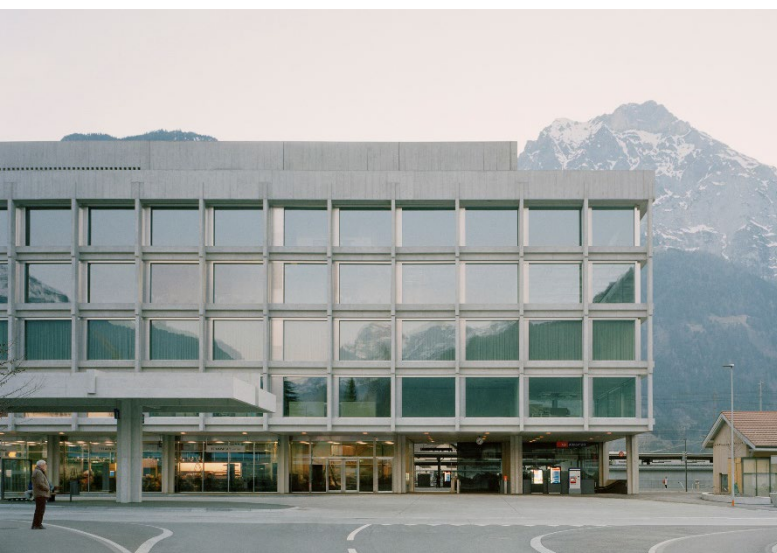
Bhf#1 Neubau Bahnhofplatz 1, Altdorf (Foto: Rory Gardiner)
