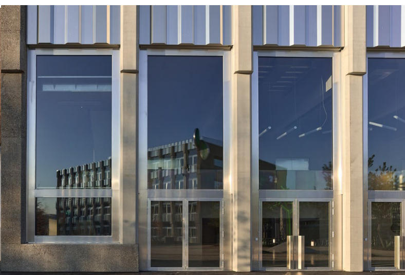
Erweiterungsbauten Kantonsschule Limmattal, Urdorf (Foto: Igor Ponti)
