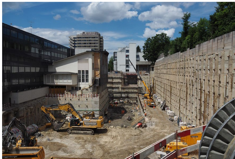
Neubau Forschungsgebäude GLC, ETH Zürich Areal Zentrum
