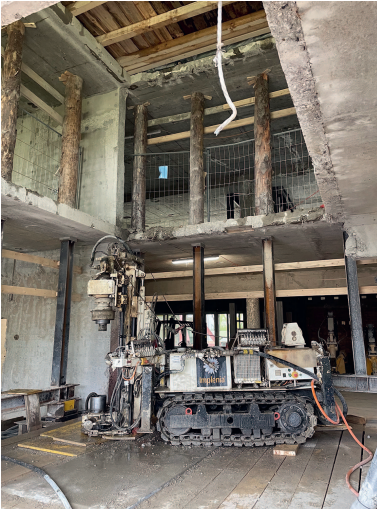
Fig. 6 Mikropfahlbohrgerät Treppenhaus Ost, Bohrplanum auf Plattform im EG. Micropile drilling rig in the east stairwell, with the drilling platform at ground floor level.
