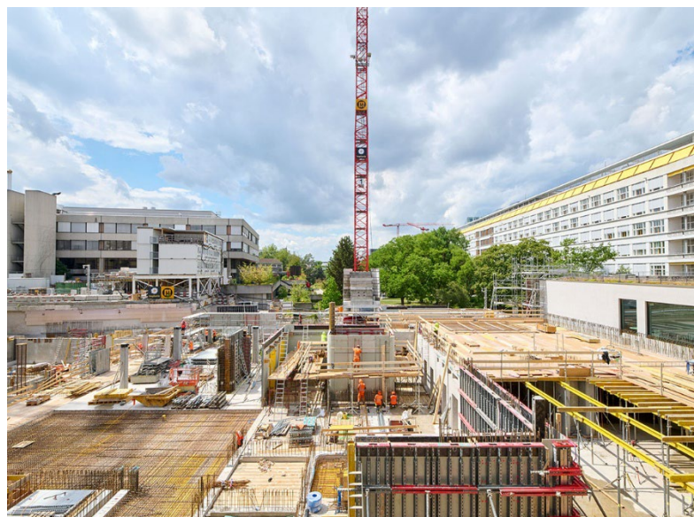
Neubau Klinikum 2, Universitätsspital Basel (Foto: Studio Willen)
