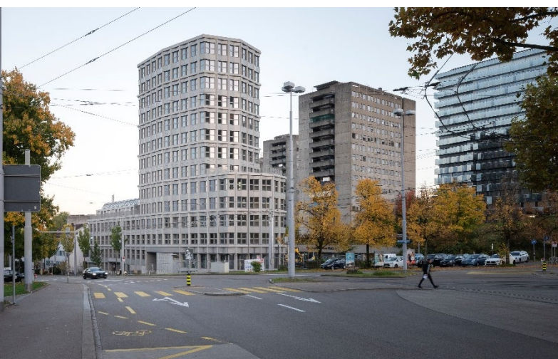
Sphinx – Hochhaus, Zürich (Foto: Alexander Gebetsroither)
